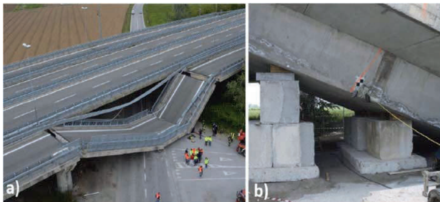
Figura 7: Pasqyrë e urës së shembur Fossano (a) dhe skemës strukturore (b).
