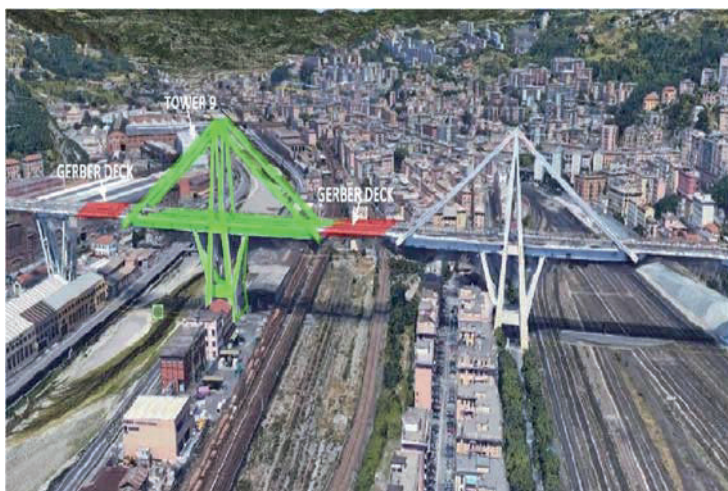
Figura 13: Struktura e përfshirë në shembje: kulla dhe kuvertat Gerber
